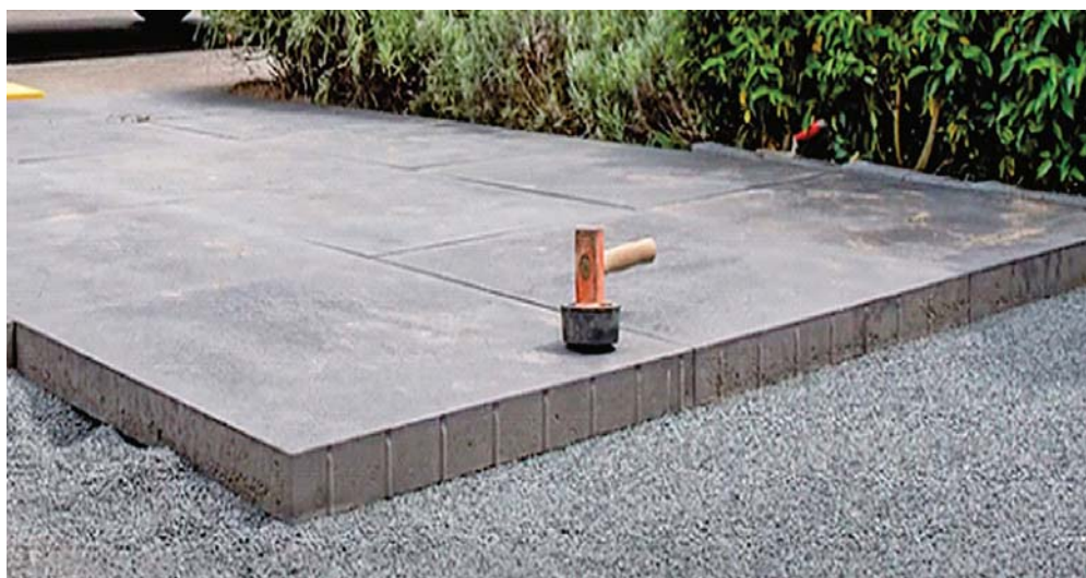
Slika 1. Postava velikoformatnih ploča na pješčanu posteljicu
